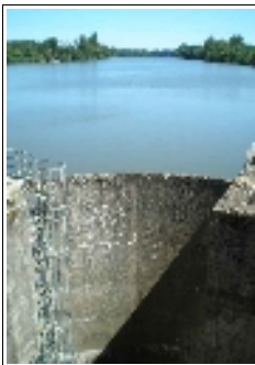
Le barrage au fil de l'eau à Rivières
