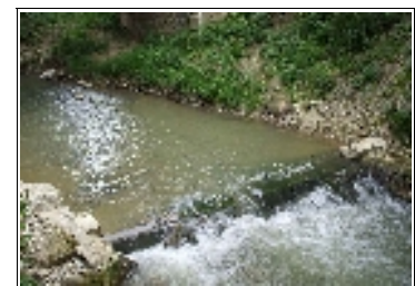
Le Bagas ainsi que d'autres petits cours d'eau dans le Tarn ont désormais des seuils de mesures de débits.
